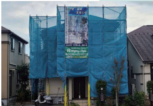
仮設工事(足場)
