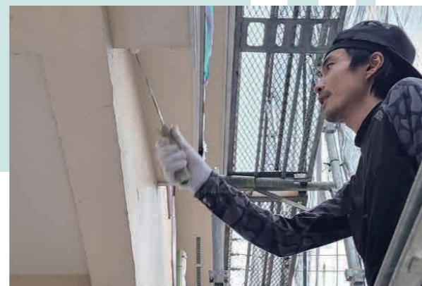
屋根・外壁塗装
