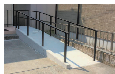
スロープの設置
